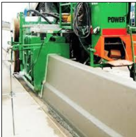
شکل ۴: قالب لغزان افقی
