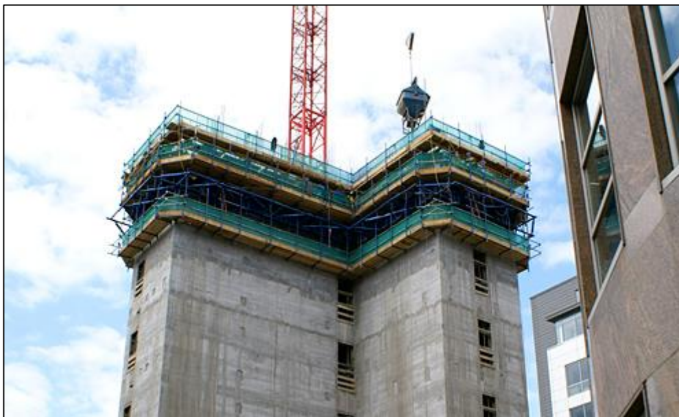
شکل ۳: استفاده از قالب لغزان قائم
